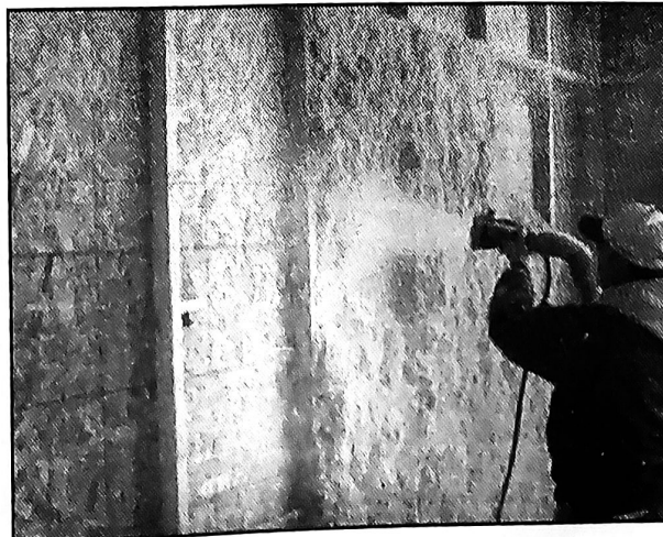
Fig. 4.26 : Installing Cellulose Insulation
